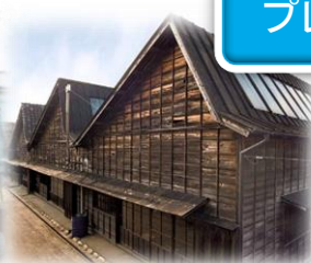
ノコギリ屋根工場
